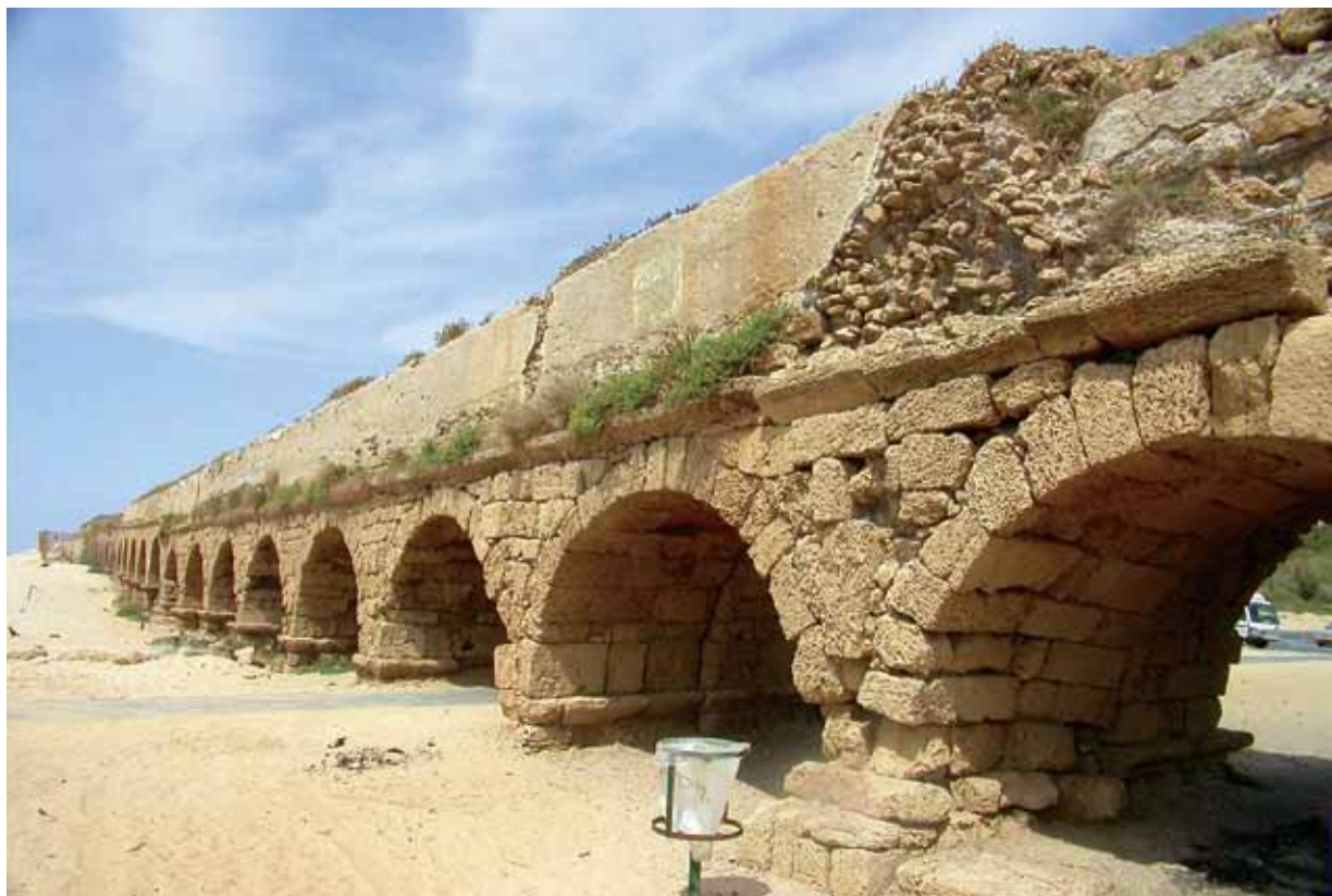
凱撒利亞導水道的遺跡
